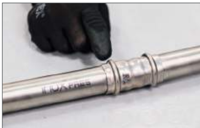
Controllo della pressatura / Checking the press connection
