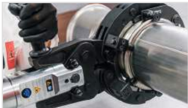
Assemblaggio pressatura n°2 / Press assembly phase 2
