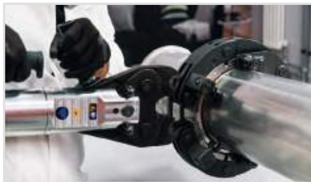
Assemblaggio pressatura n°1 / Press assembly phase 1
